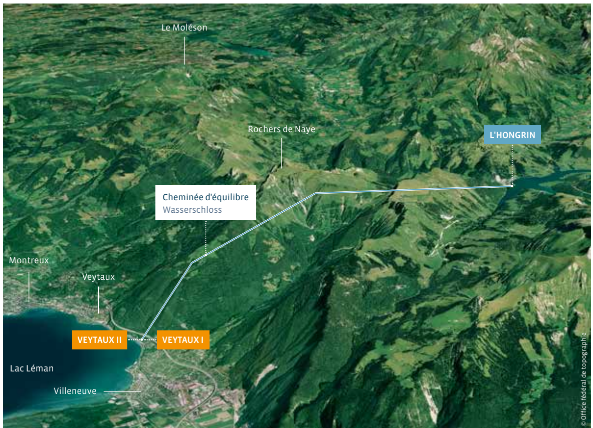
L'aménagement hydroélectrique des FMHL Der Wasserkraftwerkskomplex FMHL
