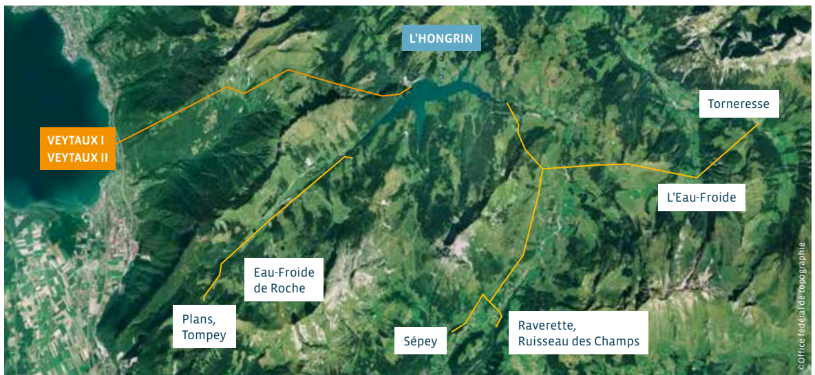
Huit prises d'eau récoltent les eaux sur une surface de 45 km 2 Acht Wasserfassungen sammeln Wasser im Einzugsgebiet von 45 km 2
